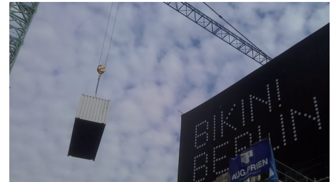
Bikini Baustelle , Berlin 2012-2013
